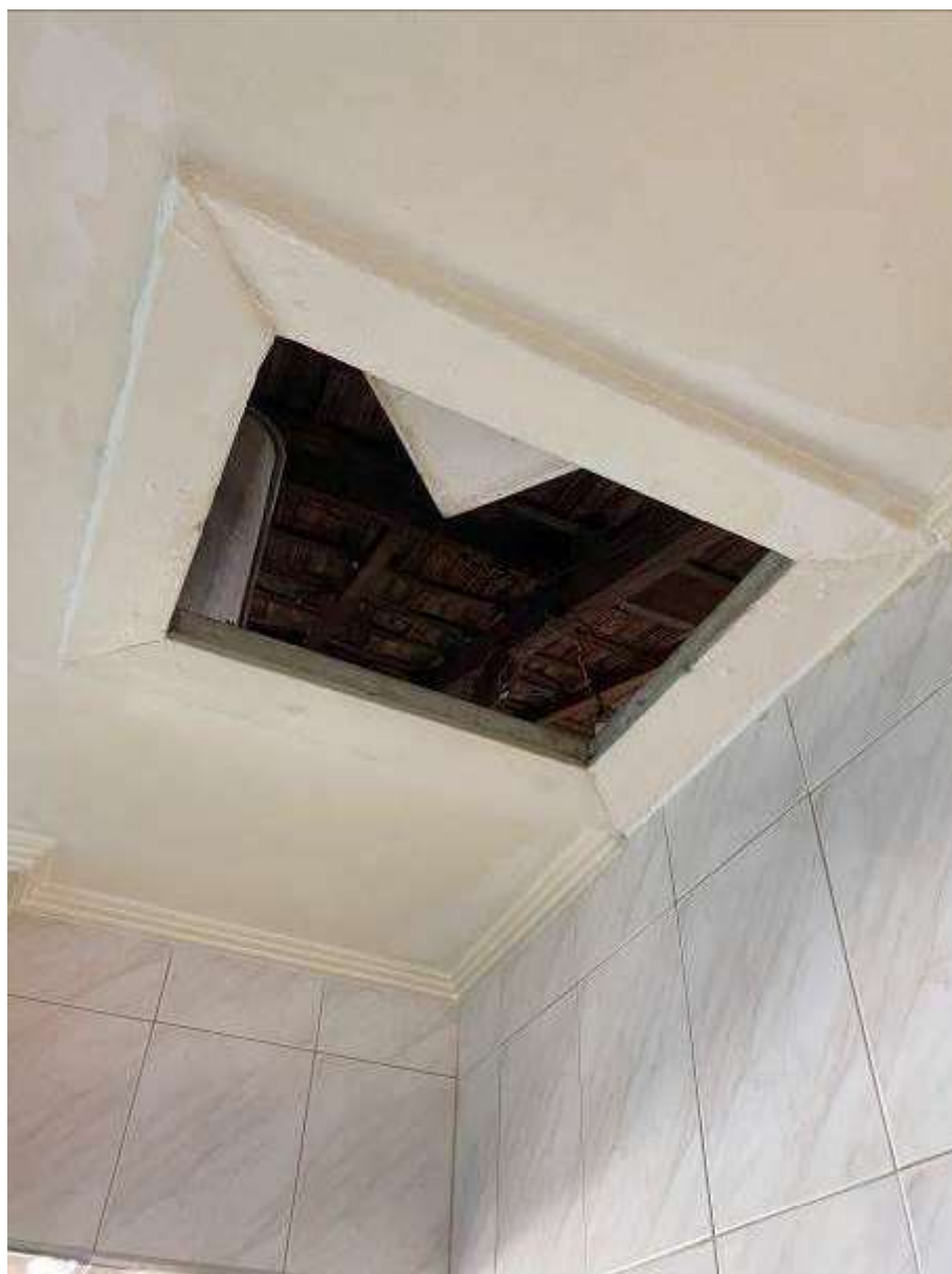
Foto 78: Vista do alçapão de acesso ao telhado.
