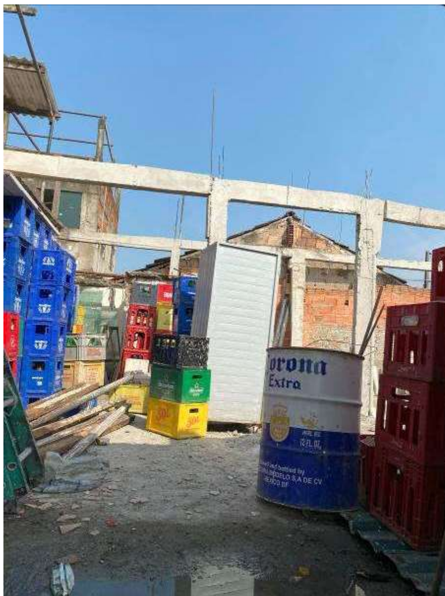
Foto 82: Vista geral do imóvel do Réu, na área anteriormente geminada ao imóvel da Autora.
