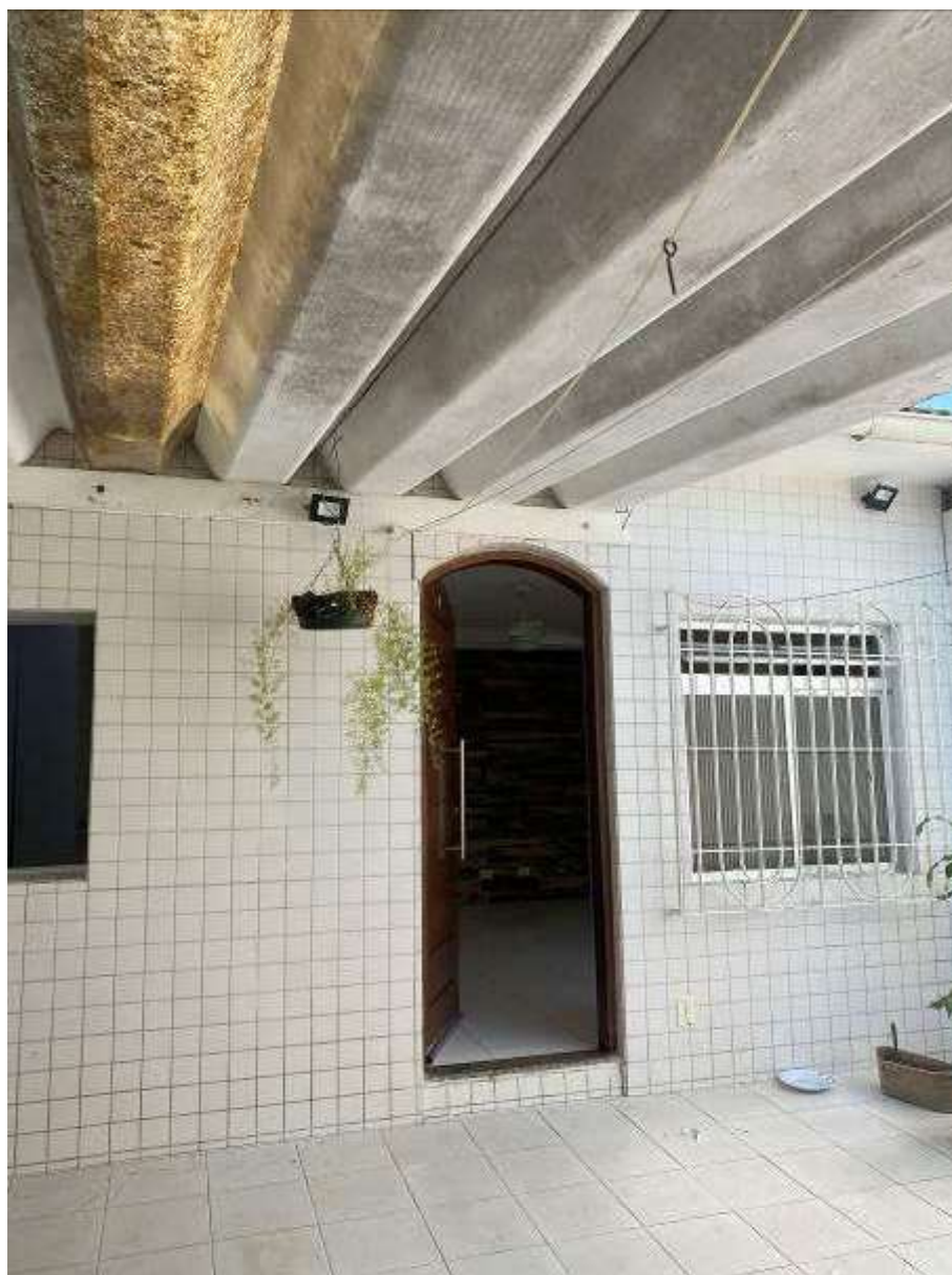
Foto 12: Vista da área externa frontal do imóvel.
