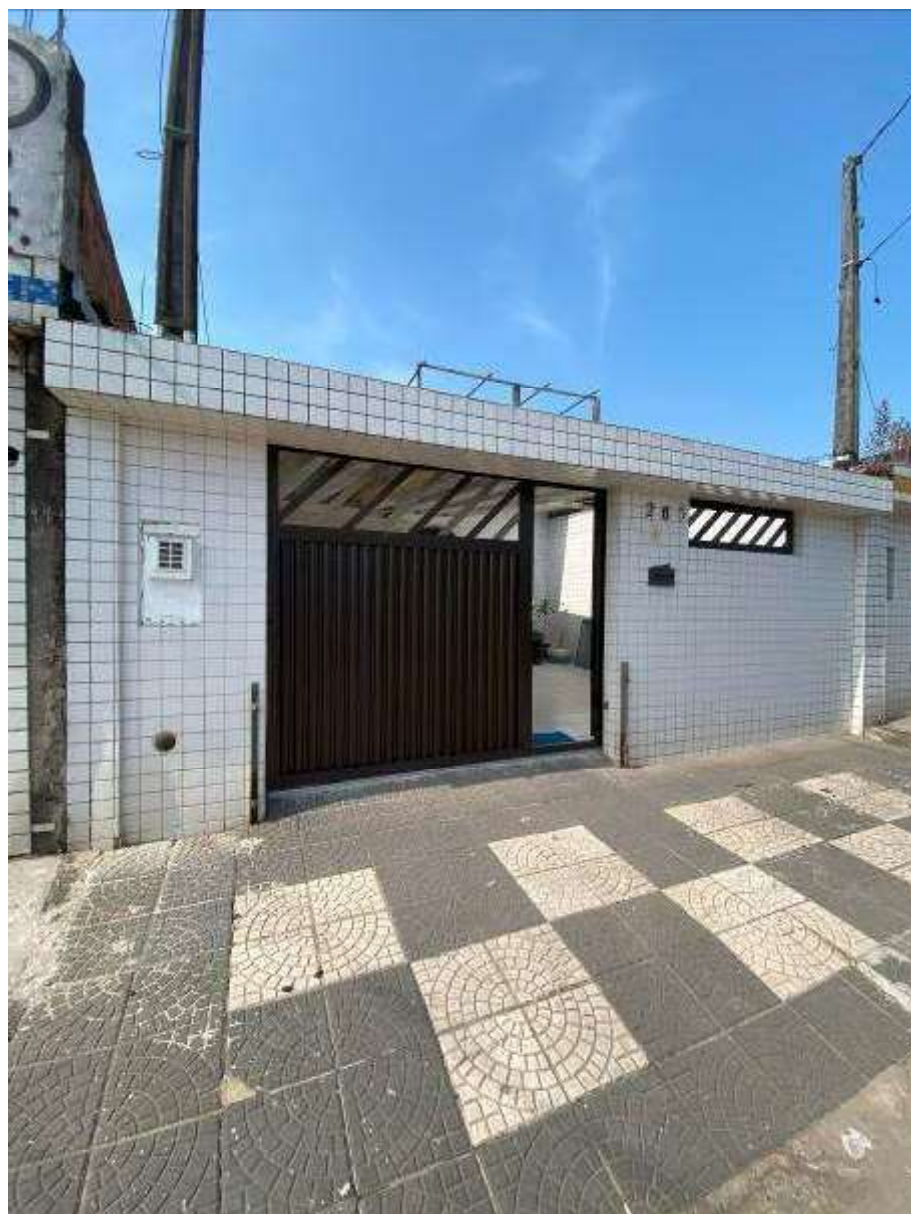
Foto 03: Vista da fachada do imóvel da Autora.
