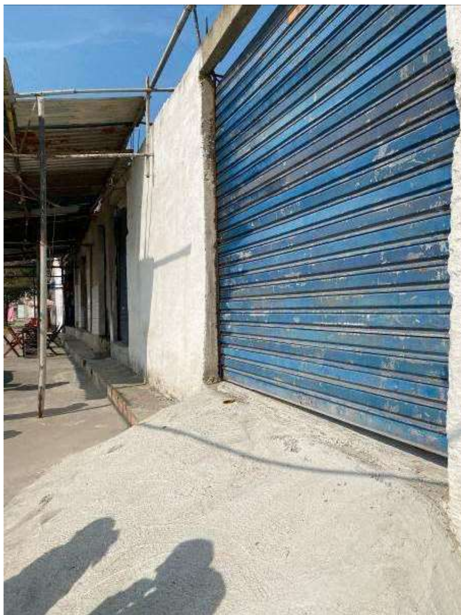
Foto 05: Vista da fachada do imóvel do Réu.
